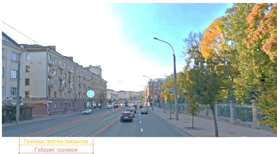
Рис. 1. Внешний вид трамвайного пути, уложенного с мощением мелкоштучными материалами
